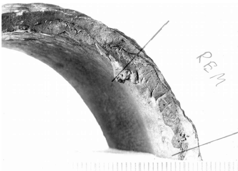
Bild 9 strukturarme Trennungsfläche hier fast über die gesamte Rohrwanddicke
