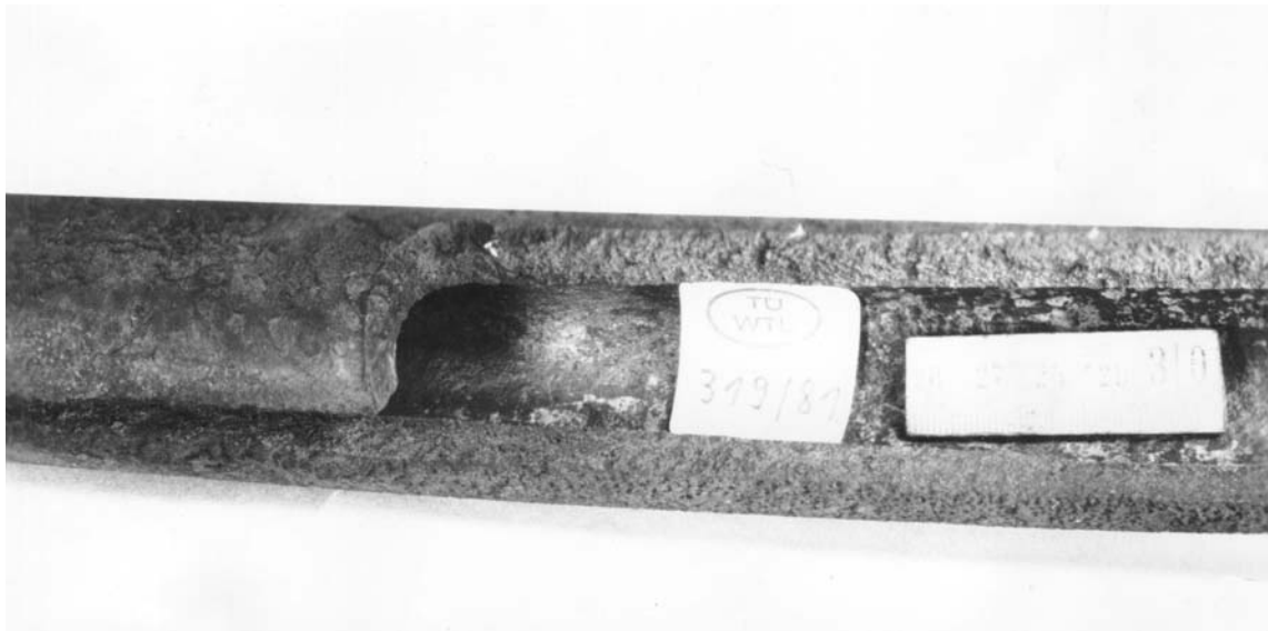
Bild 2: Bereich des Ausbruches; Bruchgefüge durchgehend strähnig, Aufnahme: SATÜ
